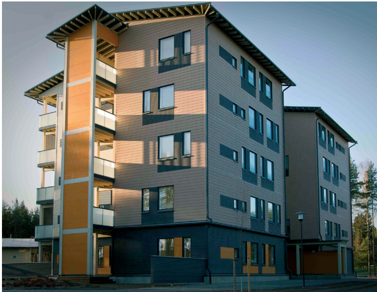
Kuva 14. Puukerrostalot ovat tyypillisiä kohteita, jotka suojataan automaattisella sammutuslaitteistolla. Kuvassa Vierumäelle rakennettu viisikerroksinen puukerrostalo.
