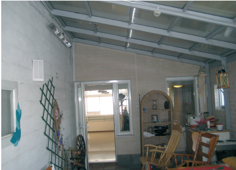
Kuva 24. Lasitettu kuisti suojattiin automaattisella sammutuslaitteistolla.
