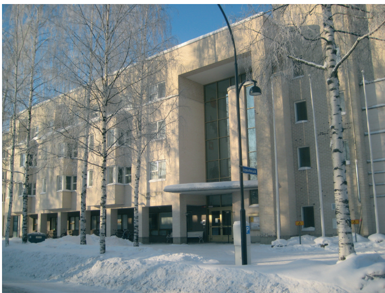
Kuva 23. Koivupihan palvelukeskus päädyttiin suojaamaan automaattisella sammutuslaitteistolla. Muitakin vaihtoehtoja poistumisturvallisuuden parantamiseksi kartoitettiin, mutta automaattinen sammutuslaitteisto osoittautui kustannustehokkaimmaksi.
